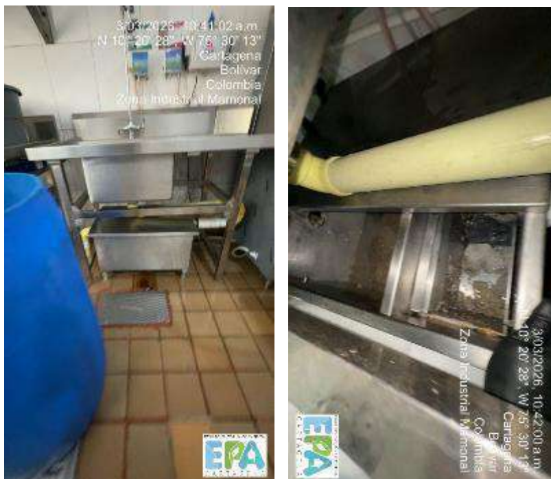
Ilustración 9. Sistema de trampa de grasa.
