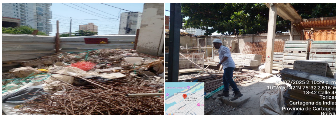
Figura 3. Acopio de RCD.
