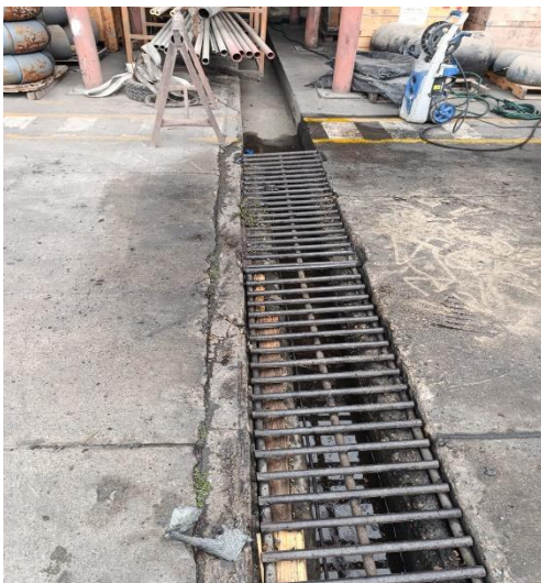
Falta mantenimiento y limpieza en canales
