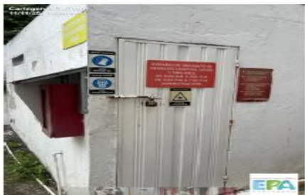
Foto 4. Cuarto de Almacenamiento
