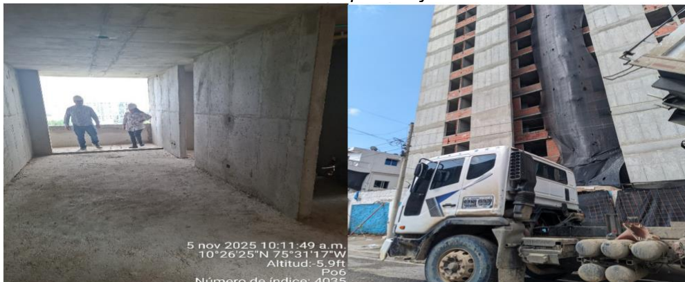
Avance de la estructura. Ilustración 2. Estado de la obra.
