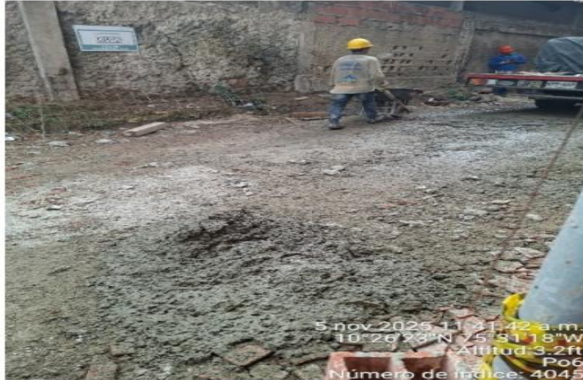
Ilustración 6. Acondicionamiento de vía interna con concreto sobrante
