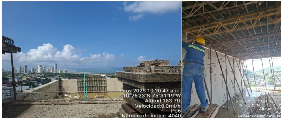
Construcción de piscina y salón social.
