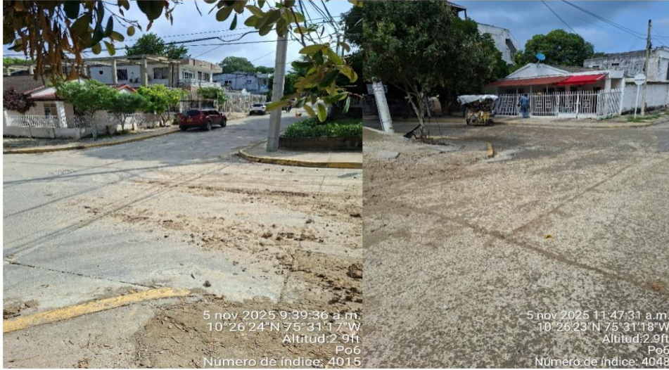
Ilustración 7. Antes y después de la limpieza de vías de acceso a la obra.
