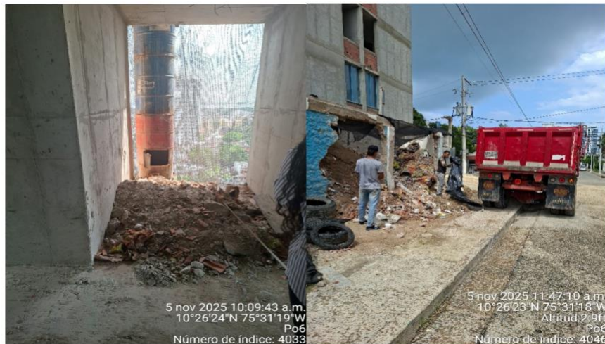
Ilustración 3. Cargue de residuos RCD – excavación y pétreos.
