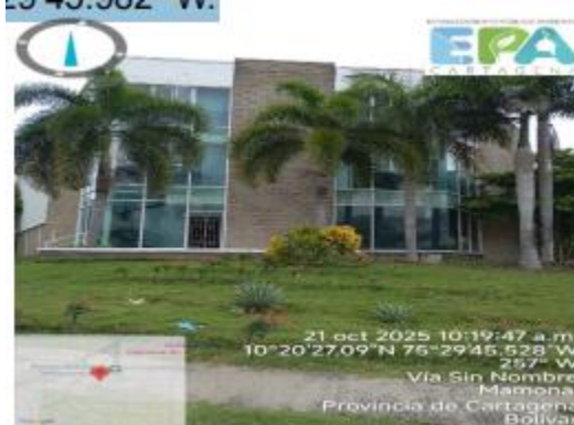
Figura 1. Fachada externa planta
