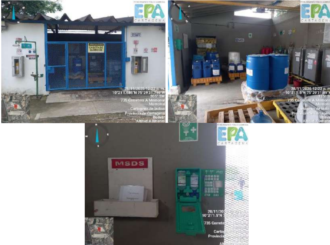
Figuras 39, 40 y 41. Centro de acopio para sustancias y productos químicos
