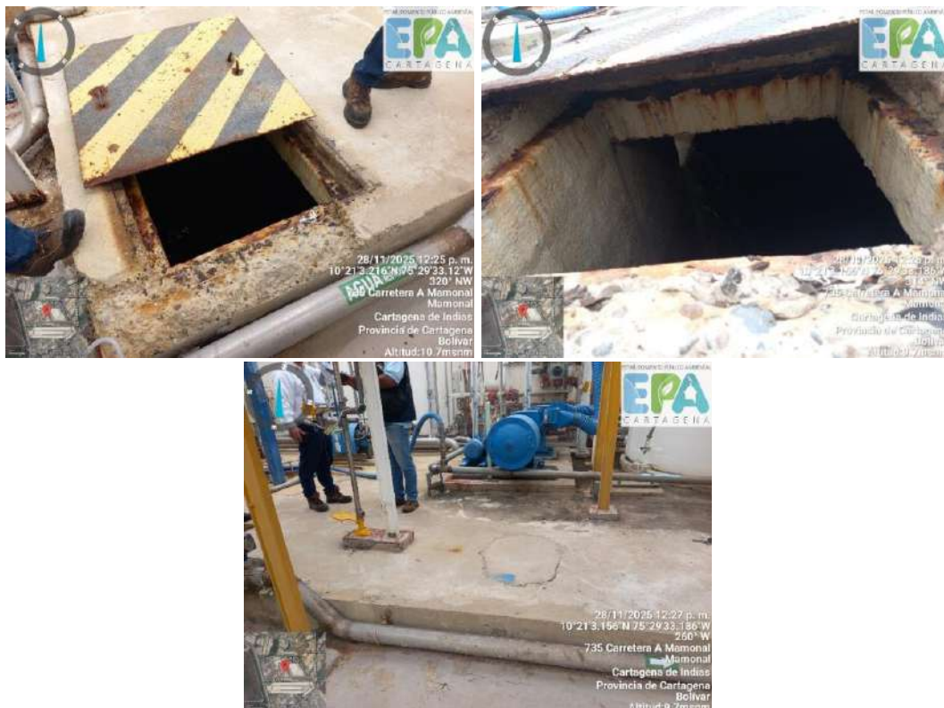
Figuras 9, 10 y 11. Poza de neutralización
