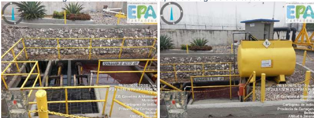
Figuras 31 y 32. Sistema API y tanque donde se depositan las aguas aceitosas
