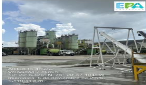
Figura 8: cangre de material a camión mezclador
