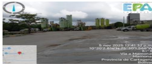
Figura 2. Planta Concretos Argos SAS
