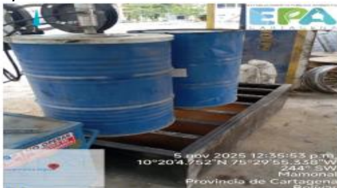
Aditivos en dique
