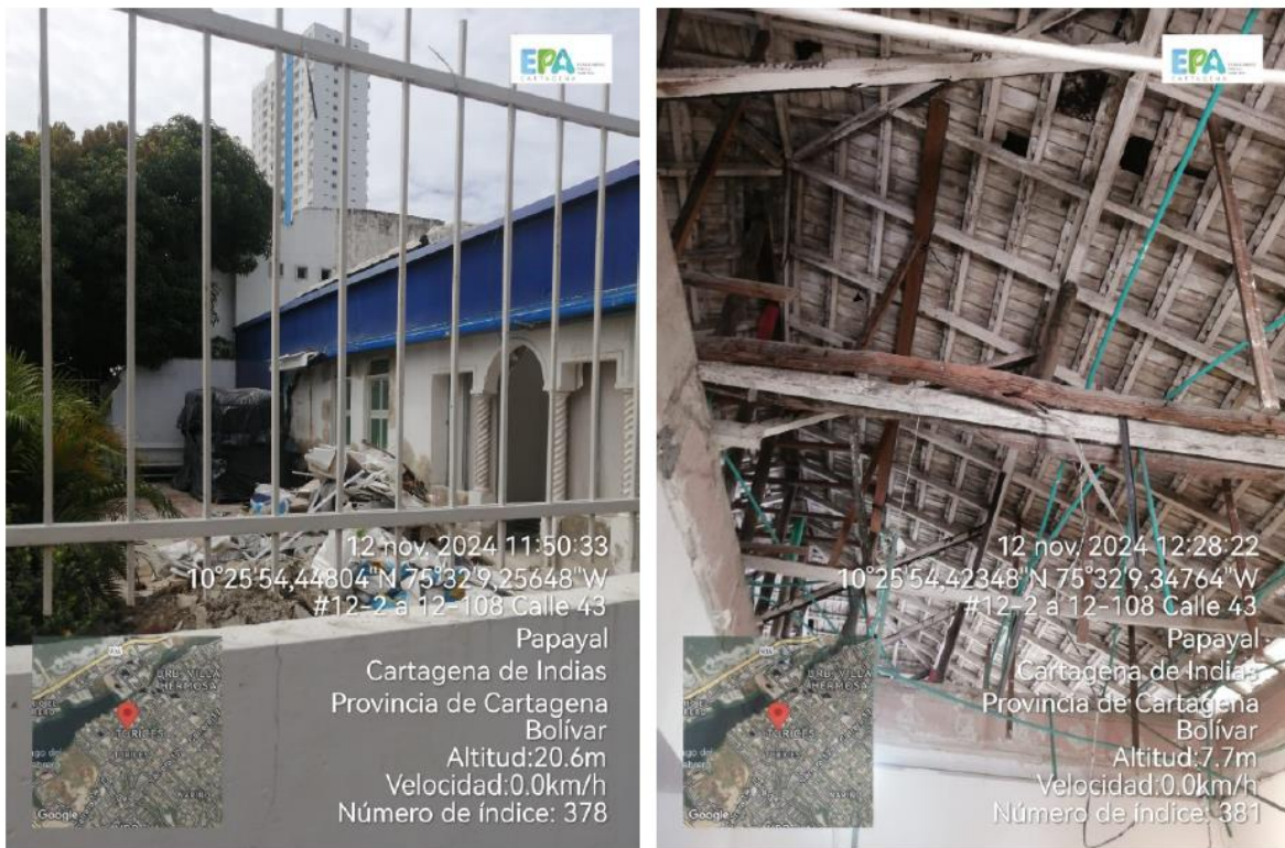
Ilustración 2. Frente de la obra en construcción y modificaciones interiores. Fuente: Autores – 2024.
