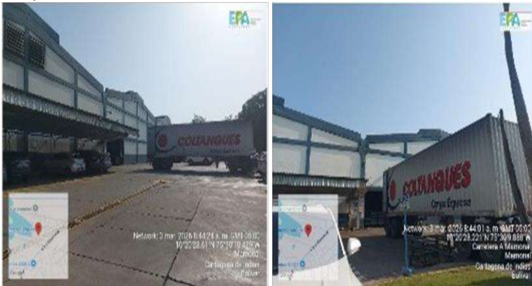
Figura 12 y 13. Áreas de Cargue y Descargue SEATECH INTERNATIONAL INC
