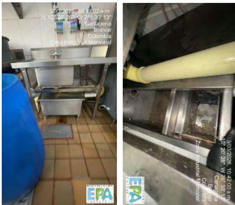
Ilustración 9. Sistema de trampa de grasa.
