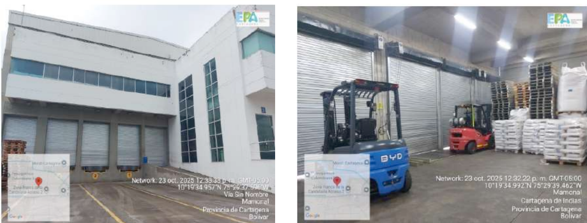
Figura 6. Área de cargue y descargue Bodega D-05 y D-06.
