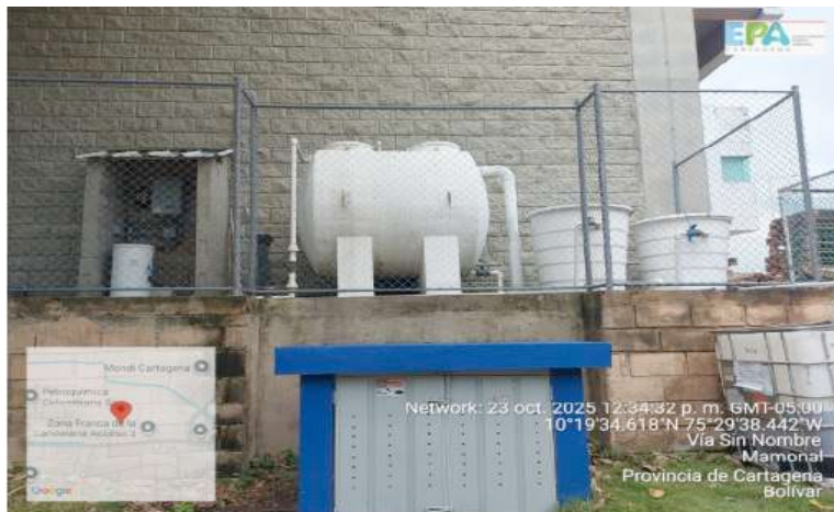
Figura 5. PTAR - Bodega D-05.
