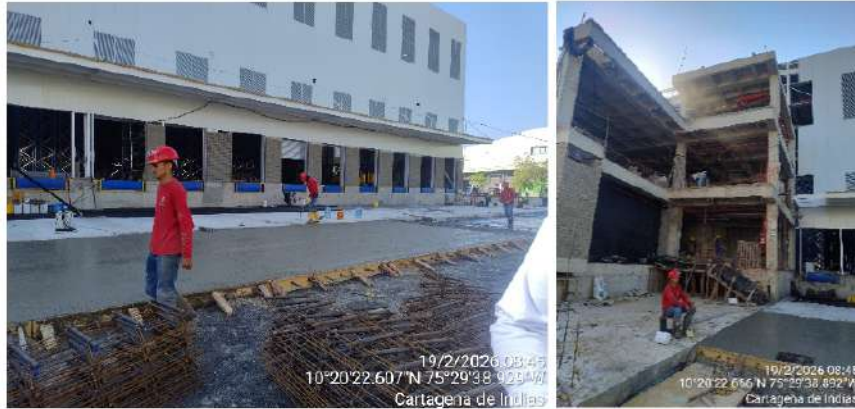
Figura 2. Actividades en ejecución del proyecto Fuente: Autores, 2026.
