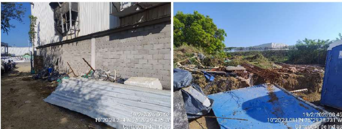
Figura 3. (a) Acopio de RCD. (b) Acopio de materiales de construcción. Fuente: Autores, 2026.
