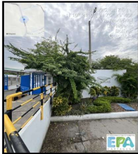
Figura 1. FACHADA DE LA EMPRESA
