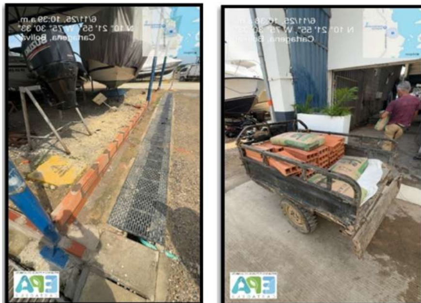
Figura 7. RCD Y ESTRUCTURA EN ADECUACIÓN
