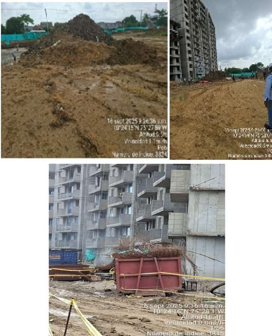
Ilustración 3. Residuos de construcción y demolición - RCD susceptibles de aprovechamiento
