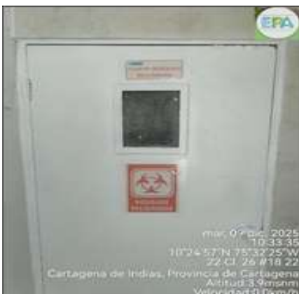
foto 6. Puerta rotulada residuos peligrosos
