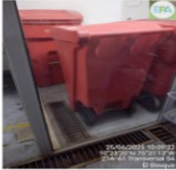
foto 7. Rejillas de desagüe al alcantarillado público.
