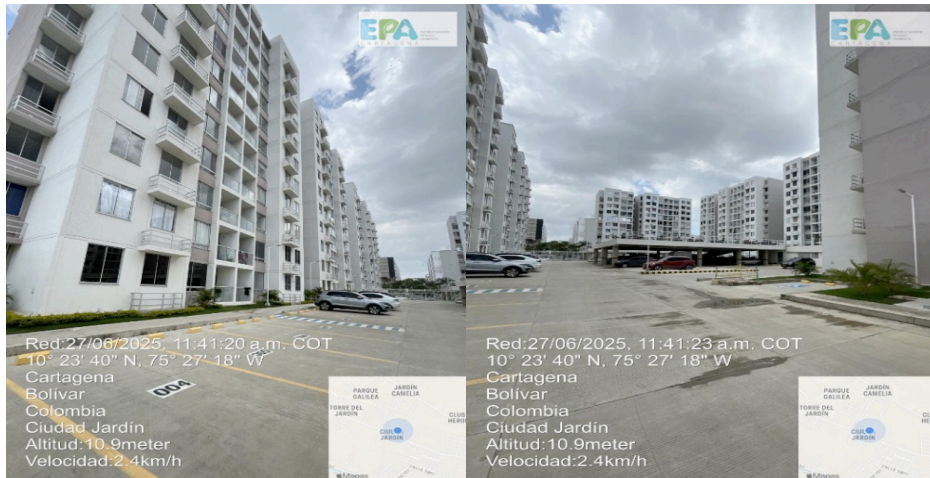
Figura 2. Entrada principal del proyecto construido EL JARDIN LAUREL. Fuente: Epa, 2025.
