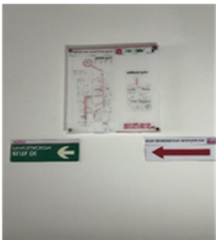
foto 7. Ruta de Evacuación
