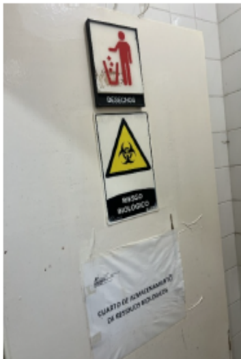
foto 3. Cuarto de almacenamiento
