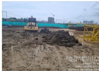
Ilustración 2. RCD producto del pilotaje. Fuente: EPA, 2024.
