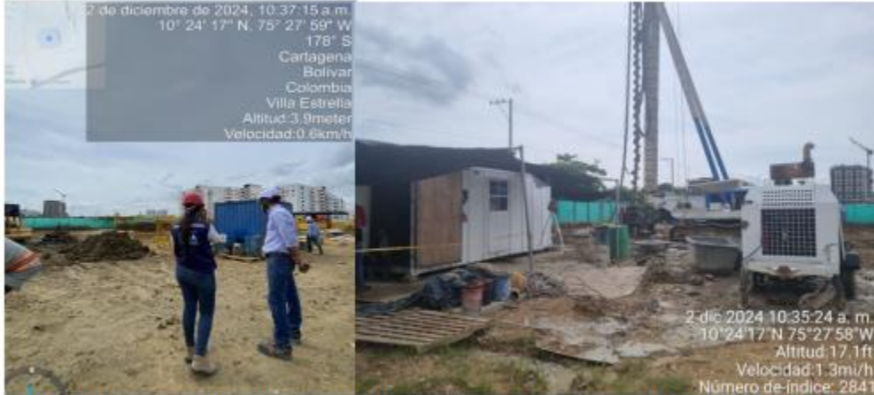
Ilustración 1. Actividades de pilotaje realizadas en el predio. Fuente: EPA, 2024.
