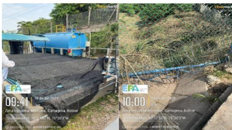
Figura 9. Canal interno LAMITECH S.A.S. Fuente: EPA CARTAGENA, 2025.
