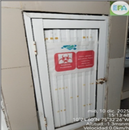
Foto 6. Puerta señalizada en el depósito.
