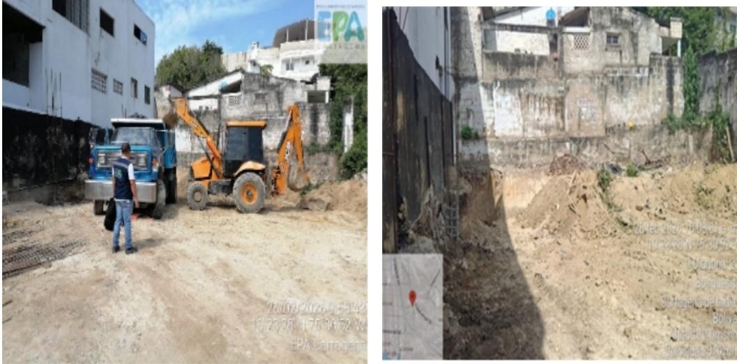
Ilustración4: actividad de excavaciones y nivelación de terreno. Fuente: Autores.
