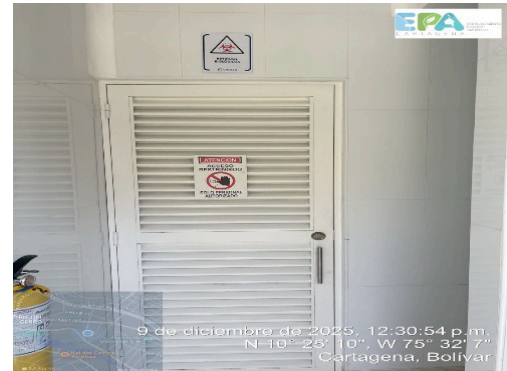
Foto 6. Cuarto de almacenamiento
