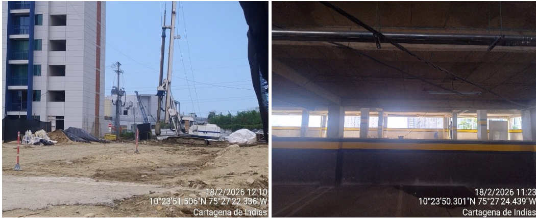
Figura 2. Actividades en ejecución. Fuente: Autores, 2026
