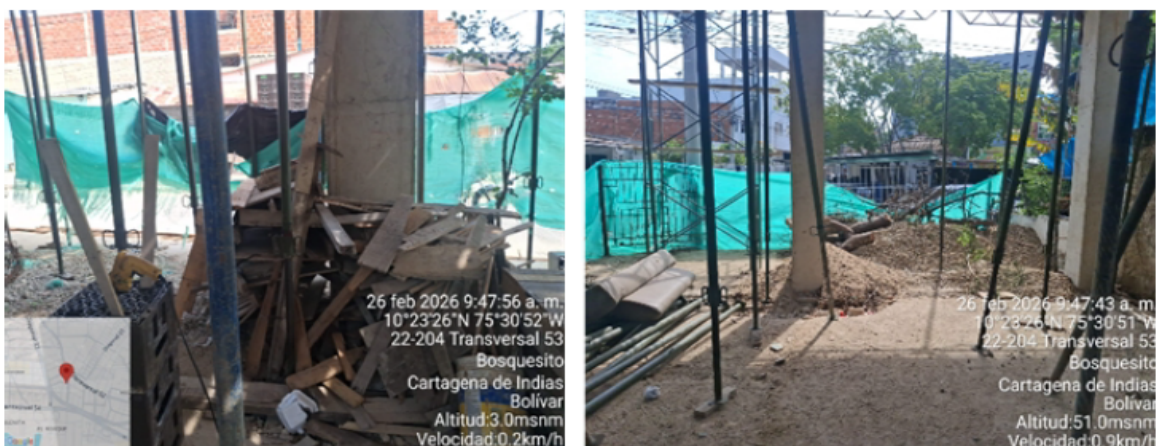
Ilustración 5: Residuos de Construcción y Demolición RCD. Fuente: Autores.
