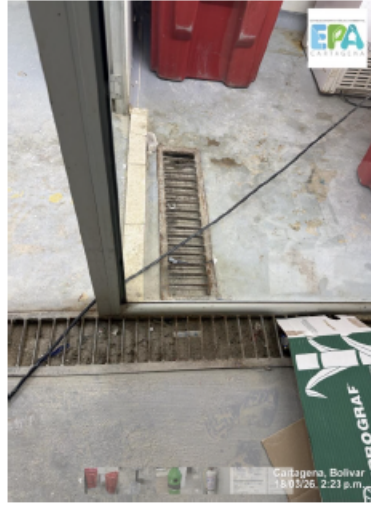
foto 5. Dique de contención
