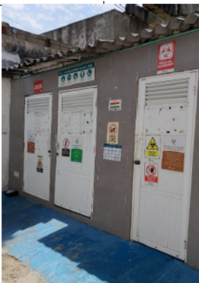
foto 4. cuarto de almacenamiento
