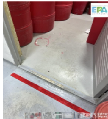
foto 5. Dique de contención
