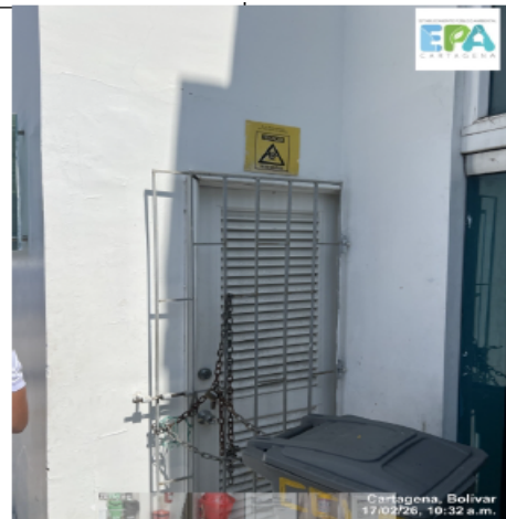
foto 4. cuarto de almacenamiento
