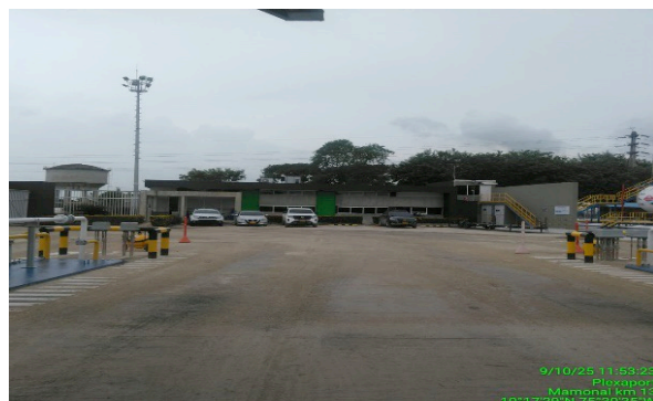
Figura 2. Fachada interna planta
