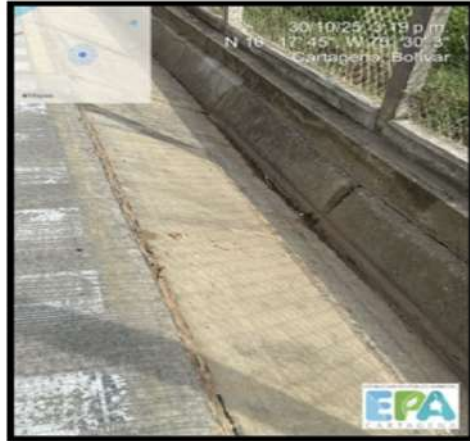
Figura 14. MATERIA PRIMA EN CANAL DE AGUAS LLUVIAS
