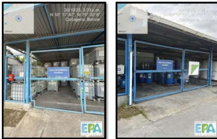
Figura 33. CENTRO DE ACOPIO DE SUSTANCIAS QUÍMICAS.
