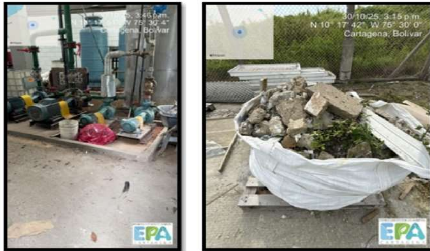
Figura 12. DISPOSICIÓN INADECUADA DE RESIDUOS
