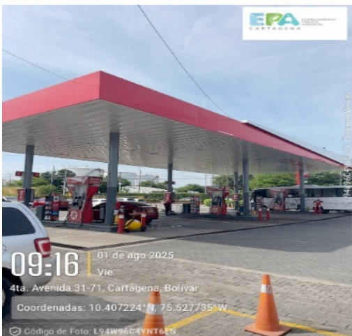
Figura 1. Estación de Servicio Zona Franca
