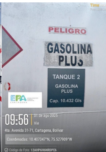
Figura 4 Tanque gasolina Plus.
