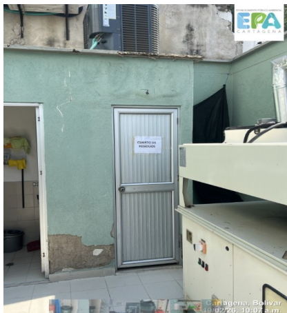
foto 5. cuarto de almacenamiento
