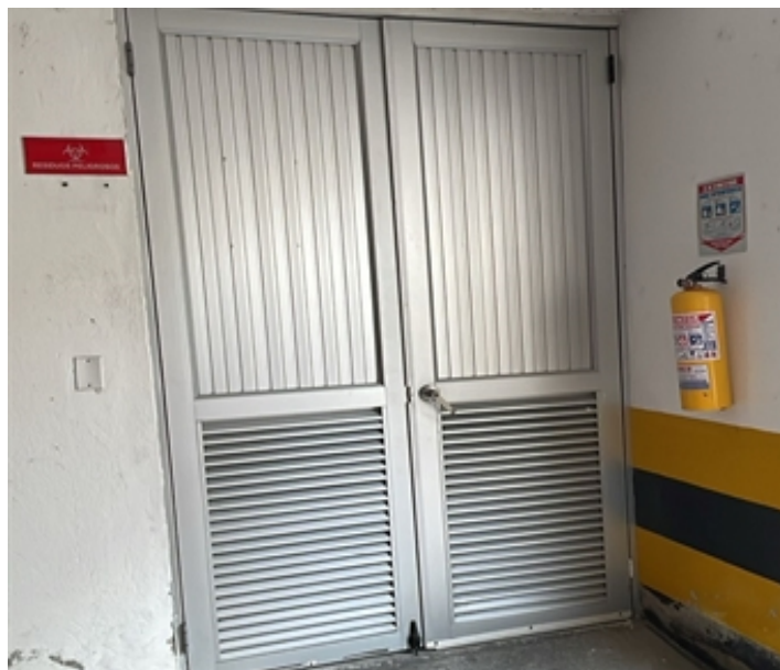
foto 5 cuarto de almacenamiento
