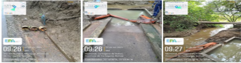
Figuras 11, 12 y 13 punto de vertimiento al canal
