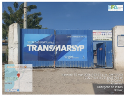
Figura 3. Fachada principal de la SOCIEDAD PORTUARIA TRANSMARSYP S.A.
