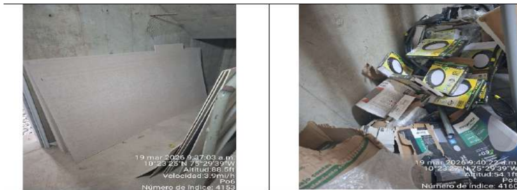
Drywall almacenado para reutilización.
