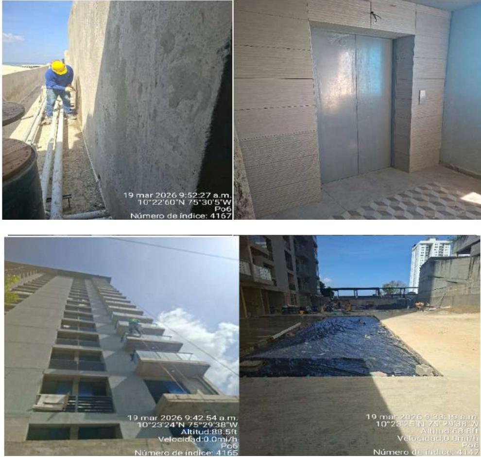
Ilustración 2. Avance de obra y actividades desarrolladas al momento de la visita.
