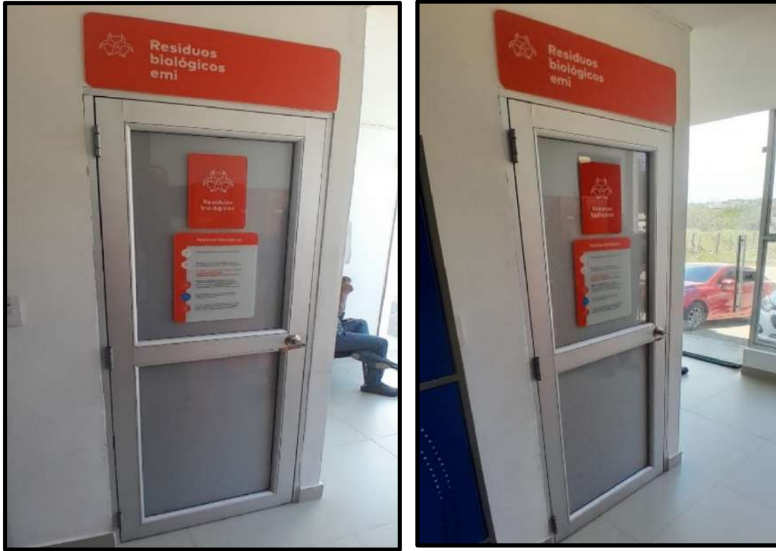
Foto 5. Almacenamiento de RESPEL (Puertas y/o accesos rotulados)
