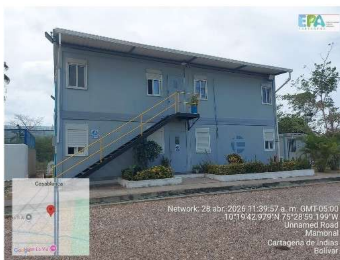
Figura 2. Fachada principal de la empresa FINCIMEC Z.F. S.A.S
