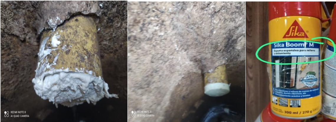
Ilustración 1. Sellamiento de la tubería de Salida de ARD Fuente: Autores 2024
