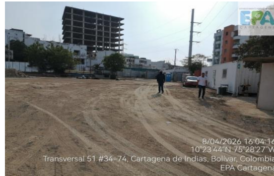
Figura 3. Adecuación de terreno
