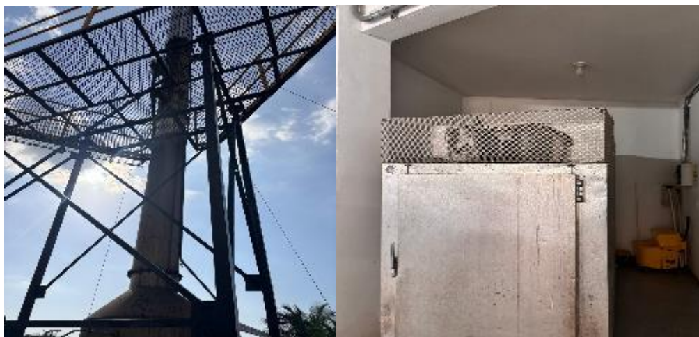
Foto 5-6. Chimenea del Horno de cremación y Cuarto frio para contingencias
