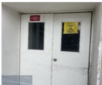
foto 2. Cuarto de almacenamiento,
