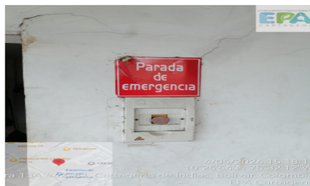
Figura 9. Para de emergencia
