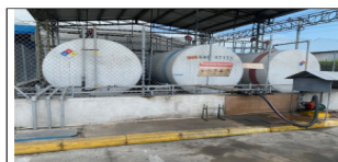
Figura 3. Tanques aéreos o de superficies
