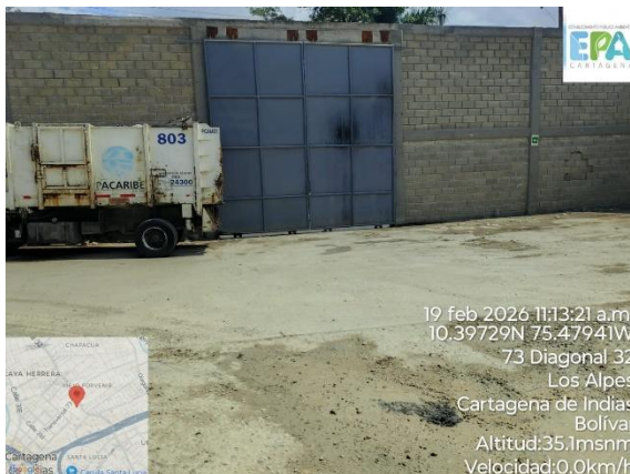
Figura 22 Puerta de ingreso y salida de vehículos pesados
