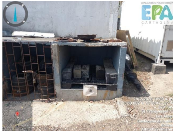
Figura 11. Centro de acopio de baterías usadas
