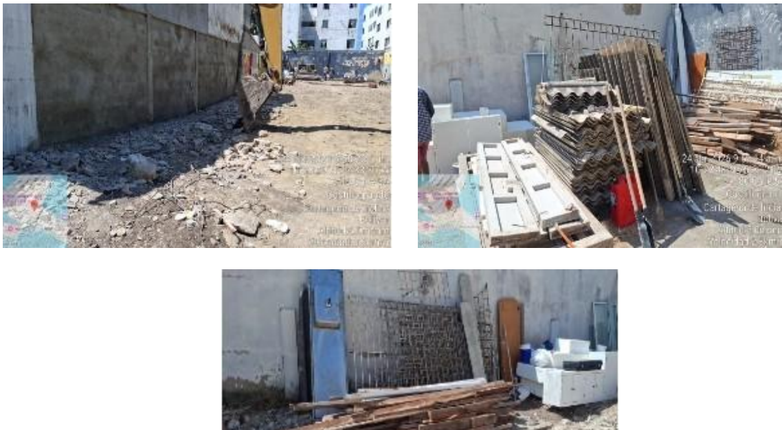
Ilustración4: excavaciones y clasificación de los RCD.
