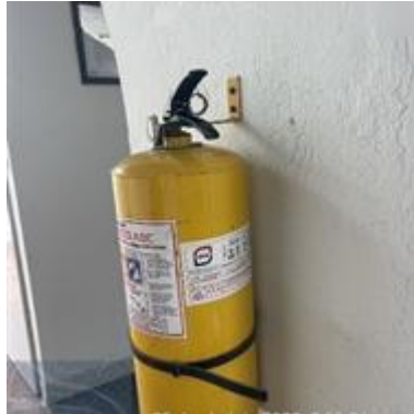
foto 2. Cuarto de almacenamiento,
